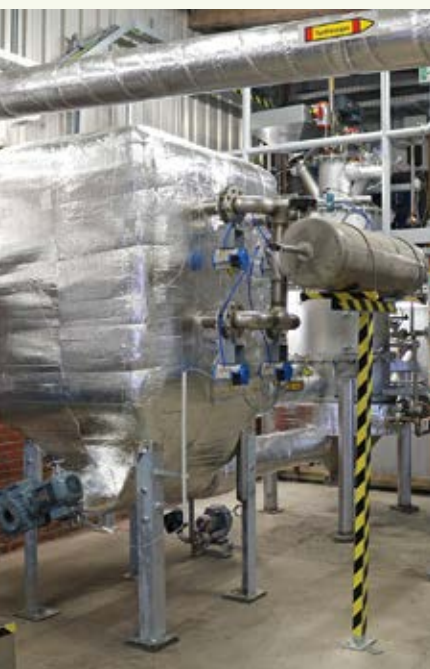
Heißgasfilter von Calida Cleantech für Holzvergaseranlagen werden individuell ausgelegt und besitzen eine automatische Abreinigung. Werkfoto
